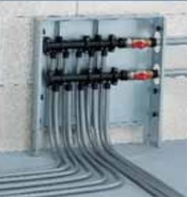
*ROTEX VA®-System: Verbund-Aluminium für die Sanitär- und Heizungsinstallation*
