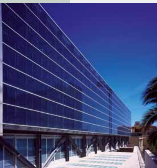
Muro cortina con paneles fotovoltaicos - La Salle - Barcelona, España (Arquitectos: Robert y Esteve Terradas Muntañola)
