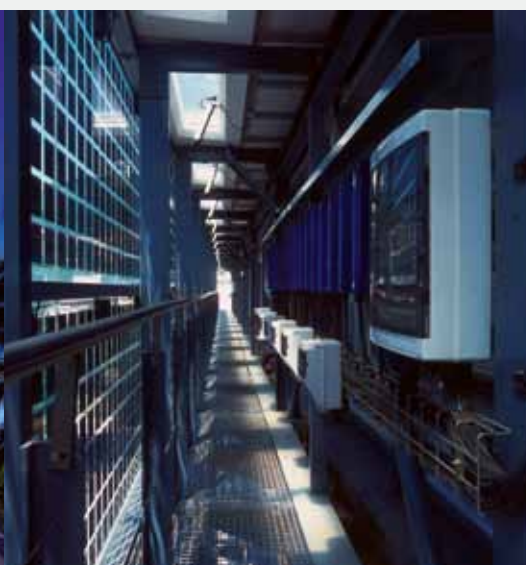
Muro cortina con paneles fotovoltaicos - La Salle - Barcelona, España (Arquitectos: Robert y Esteve Terradas Muntañola)
