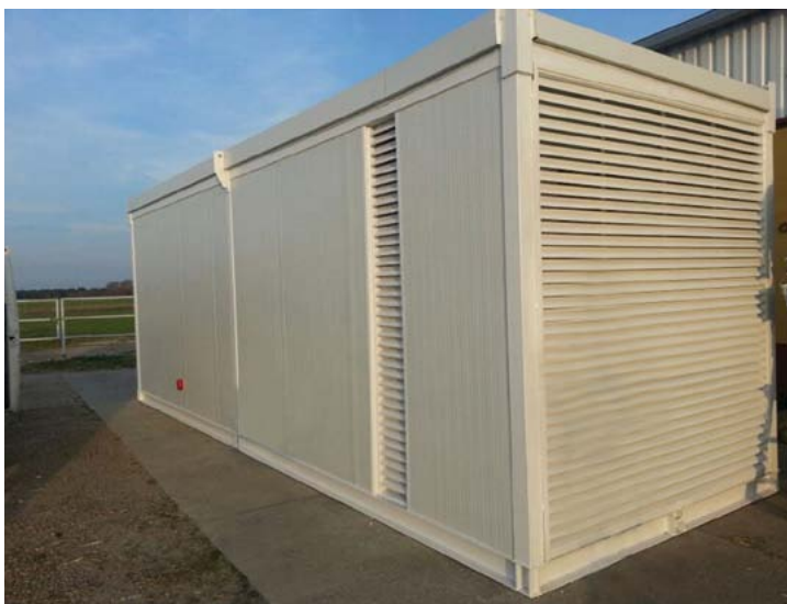
Unidad móvil de generación de energía.
