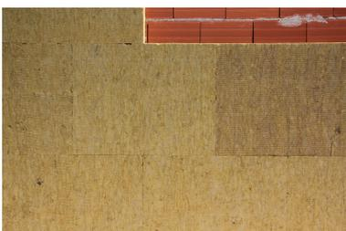
Fase 3 - La fijación de los paneles de Lana Mineral se complementa mediante anclajes de fijación mecánica, de longitud mínima igual al espesor del aislante + 30 mm aproximadamente (o según especificaciones del fabricante del anclaje).
