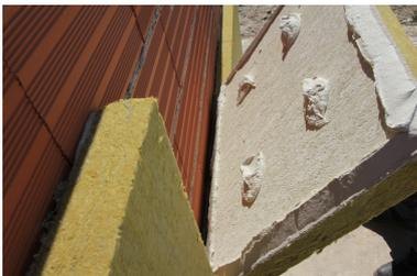
Fase 2 - Los paneles de Lana Mineral deberán colocarse en sentido ascendente (de abajo hacia arriba), con juntas verticales discontinuas (colocación a rompe-juntas).
