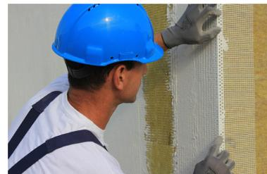
Fase 5 - Por último se procede con la aplicación del recubrimiento base, la armadura de refuerzo, la imprimación y el revestimiento final.
