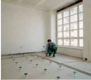
1- Posicionamiento de pedestales / Placing of pedestals
