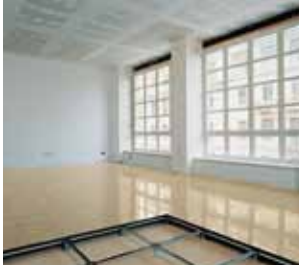
6- Acabado de los paneles terminales con relativos cortes a medida / Perimetral panels according to the final dimension
