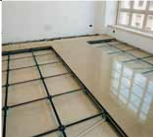
4- Formación de una "T" / "Tee" placing.
