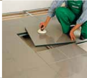
6- Acabado de los paneles terminales con relativos cortes a medida / Perimetral panels according to the final dimension
