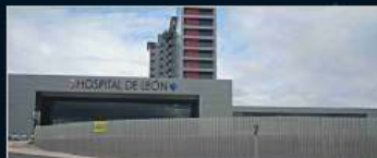
Complejo Parking - Hotel del Hospital de León
