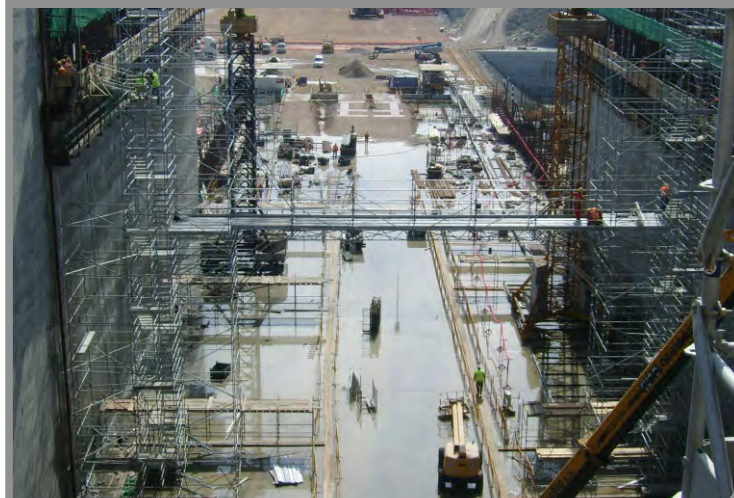
PASARELA ADRIATIC LNG - ALGECIRAS
