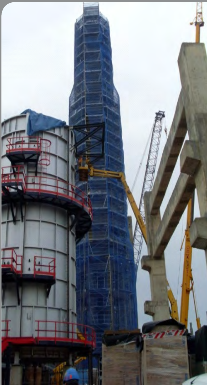
REFINERÍA CEPSA - HUELVA
