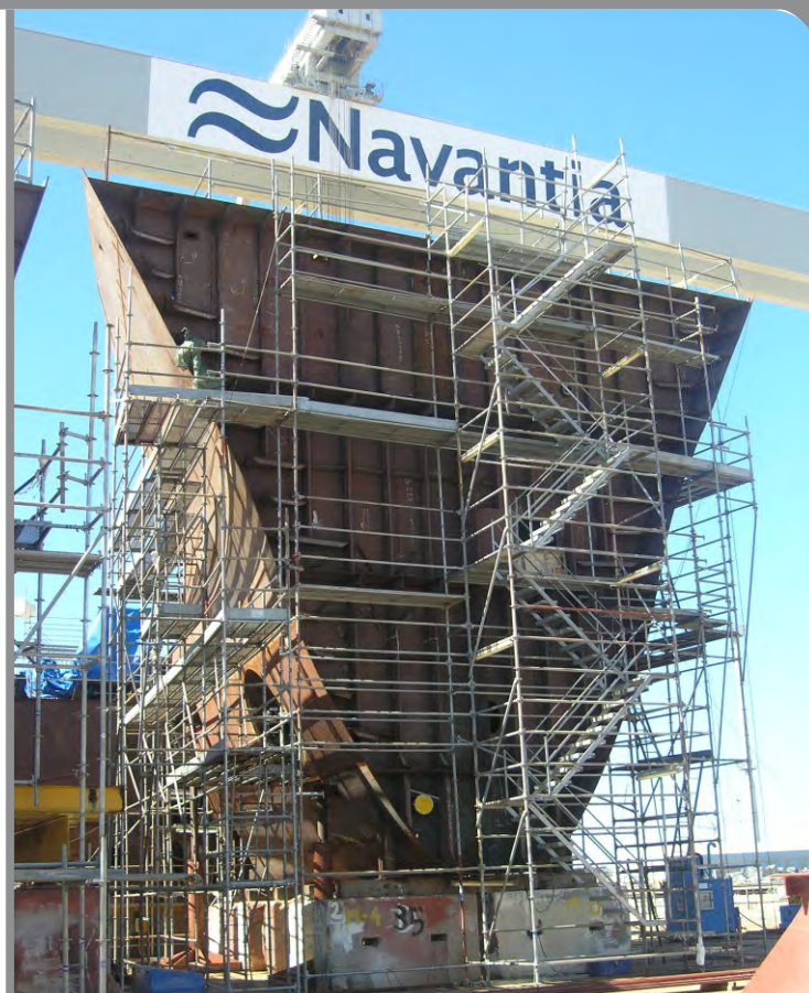
CONSTRUCCIÓN BUQUE - CÁDIZ
