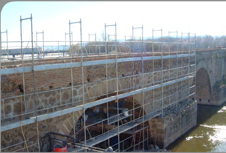
REHABILITACIÓN EN PUENTE
