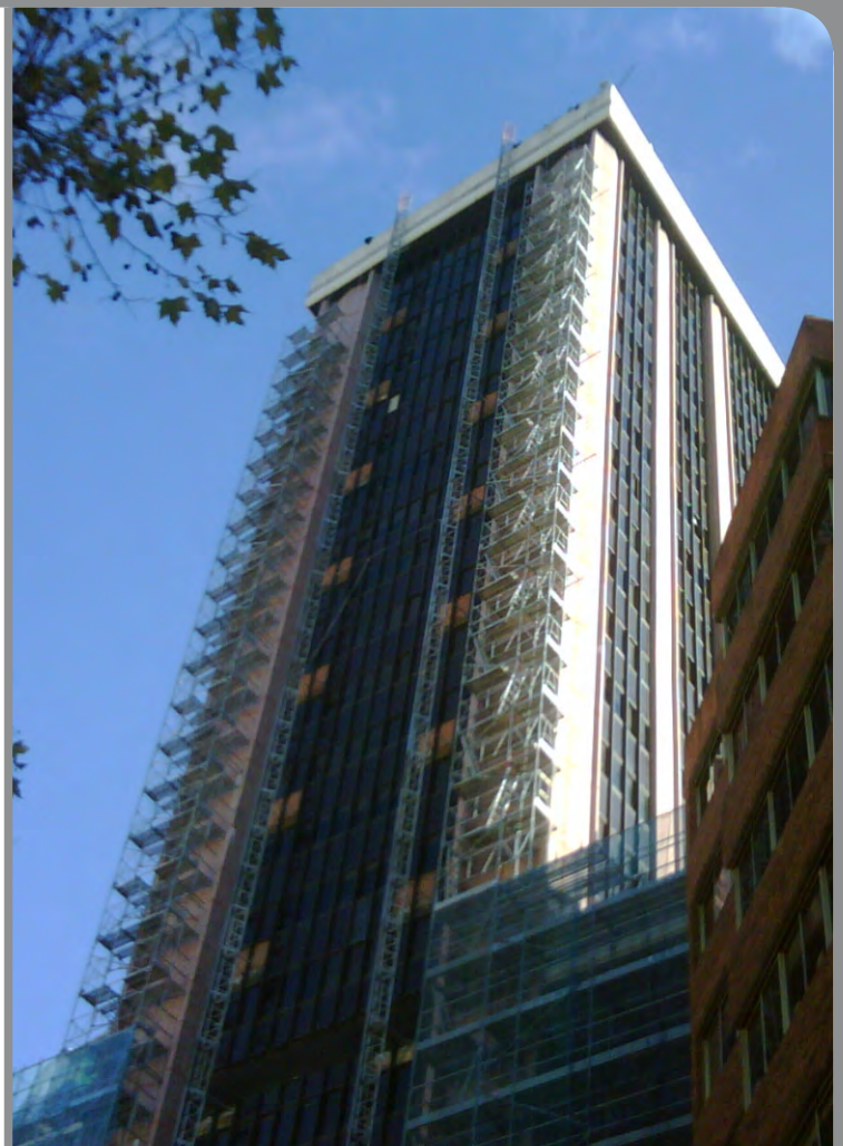
SUSTITUCION DE MUROS CORTINA
