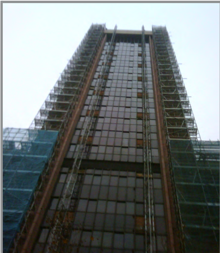
MEJORA Y REHABILITACIÓN
