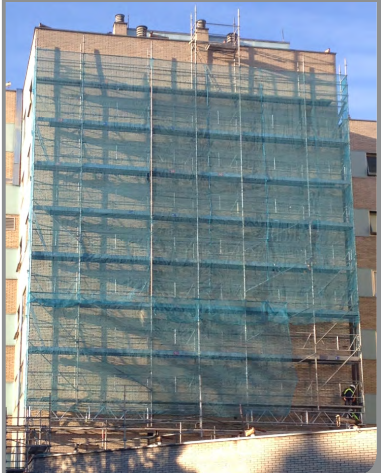
REPARACIÓN EN FACHADAS CIEGAS
