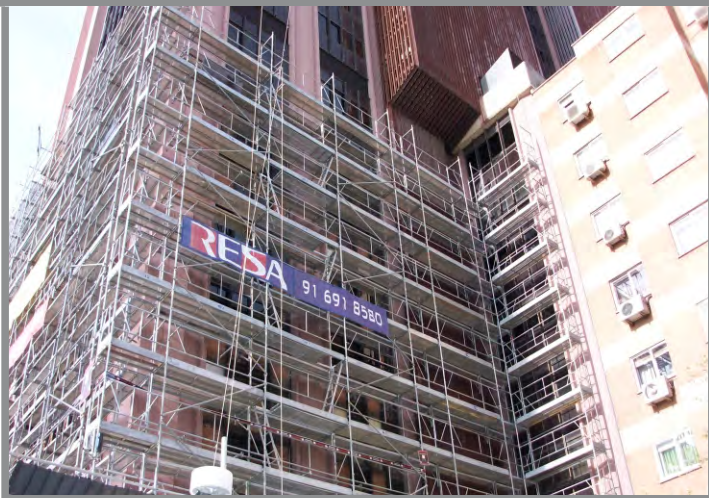
TRABAJOS VARIOS EN FACHADAS
