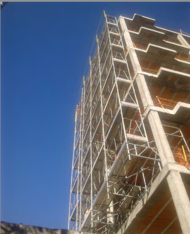
OBRA NUEVA CON VOLADO
