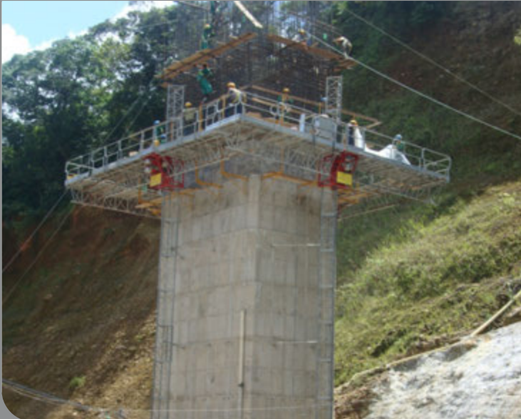
PLATAFORMA DE TRABAJO - CONSTRUCCIÓN PUENTE - COLOMBIA
