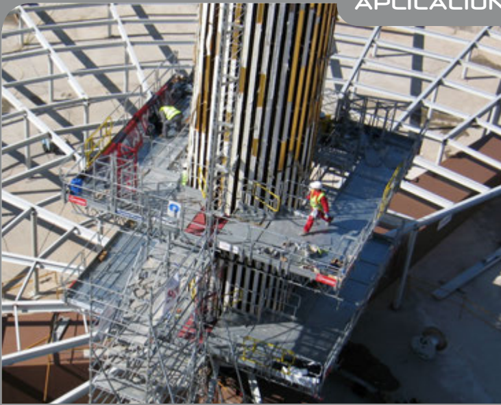
DOBLE PLATAFORMA DE TRABAJO - OBELISCO DE CALATRAVA - MADRID
