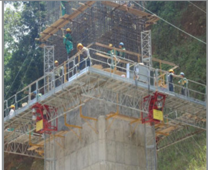
PLATAFORMA DE TRABAJO - CONSTRUCCIÓN PUENTE - COLOMBIA
