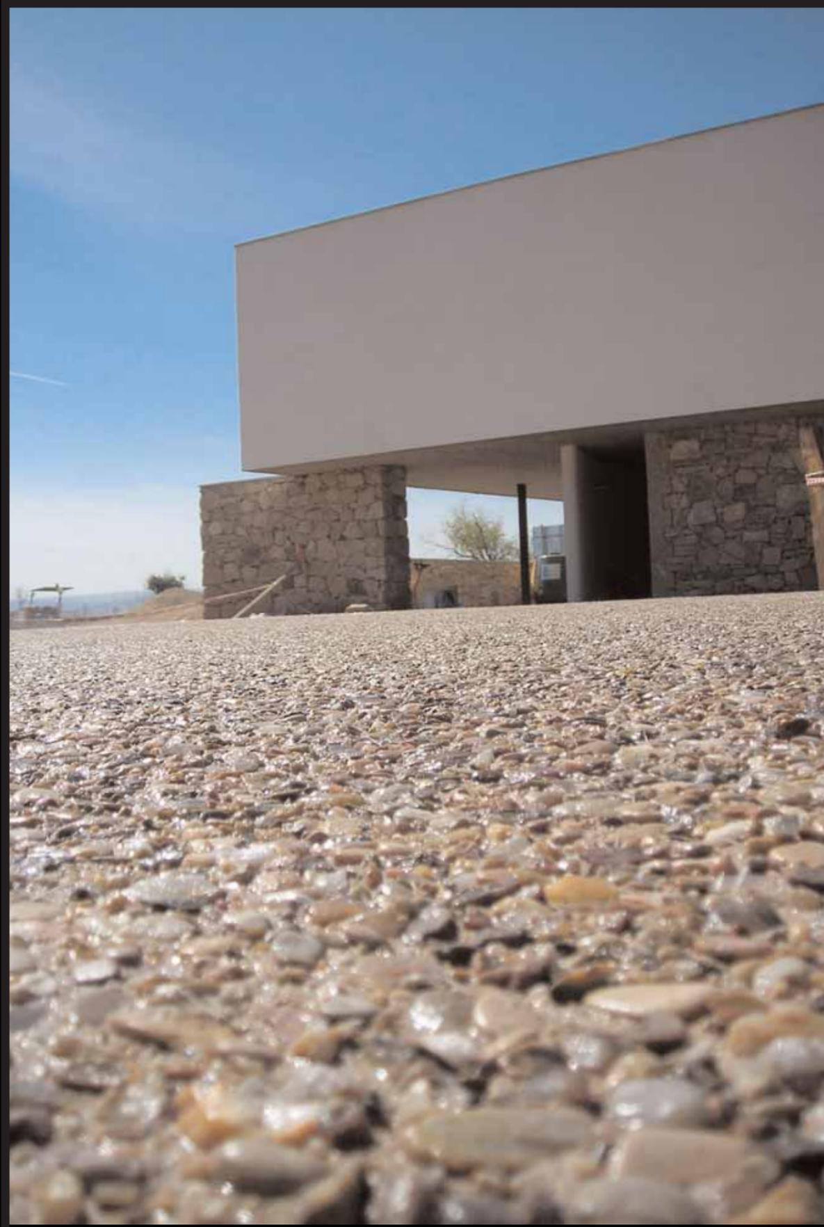
El agente desactivante permite retrasar el fraguado de la capa mas superficial del hormigón, mientras el resto de la masa experimenta un desarrollo normal del proceso de fraguado y endurecimiento. Transcurridas unas horas (normalmente entre 12 y 24 dependiendo de la temperatura) se elimina el mortero no fraguado con agua a presión dejando parte del arido al descubierto.
