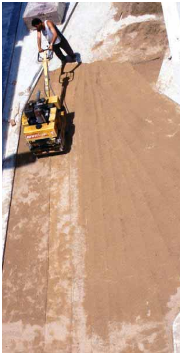
Nivelado y compactación de arena
