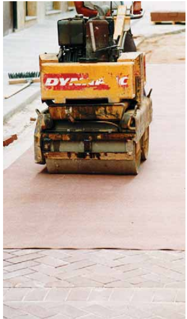
Compactado del adoquín. Utilizar vibradores con suela de goma, o bien extender una manta como en la foto para evitar desportillados
