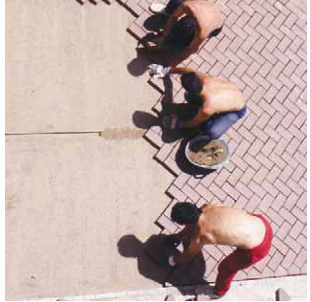
Colocación de los adoquines
