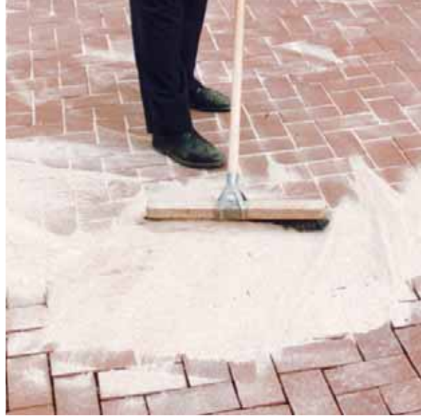
Rellenado de juntas
