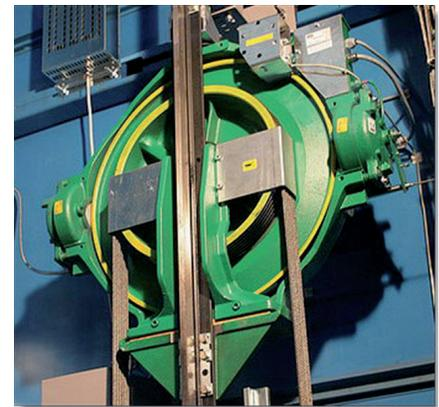
Con esta opción, el ascensor funciona como un generador cuando la cabina desciende cargada o asciende vacía. Este sistema recoge la energía devolviendo a la red hasta un 20%.
