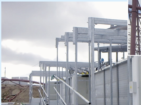
■ Montaje final de evaporadores.
