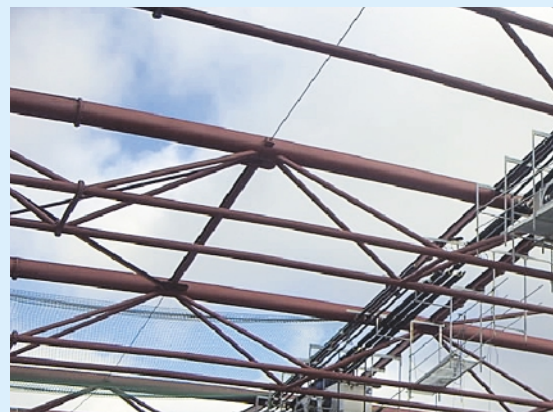
■ Montaje de estructura de evaporaciones.
