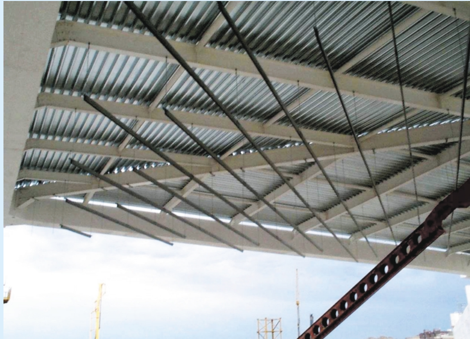
■ Montaje estructura falso techo.
