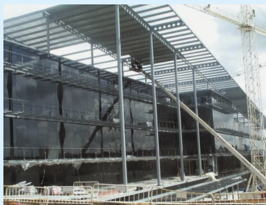
■ Detalle fachada oficinas.
