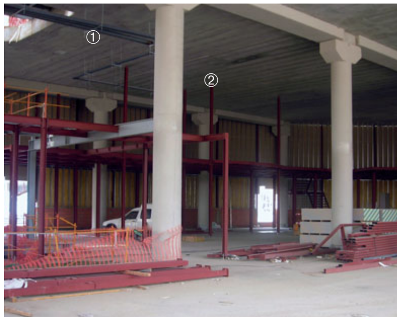
Interior Pabellón Ebro: se pueden identificar las fijaciones temporales Hilti HUS-A (1) y Hilti HUS-H (2).
