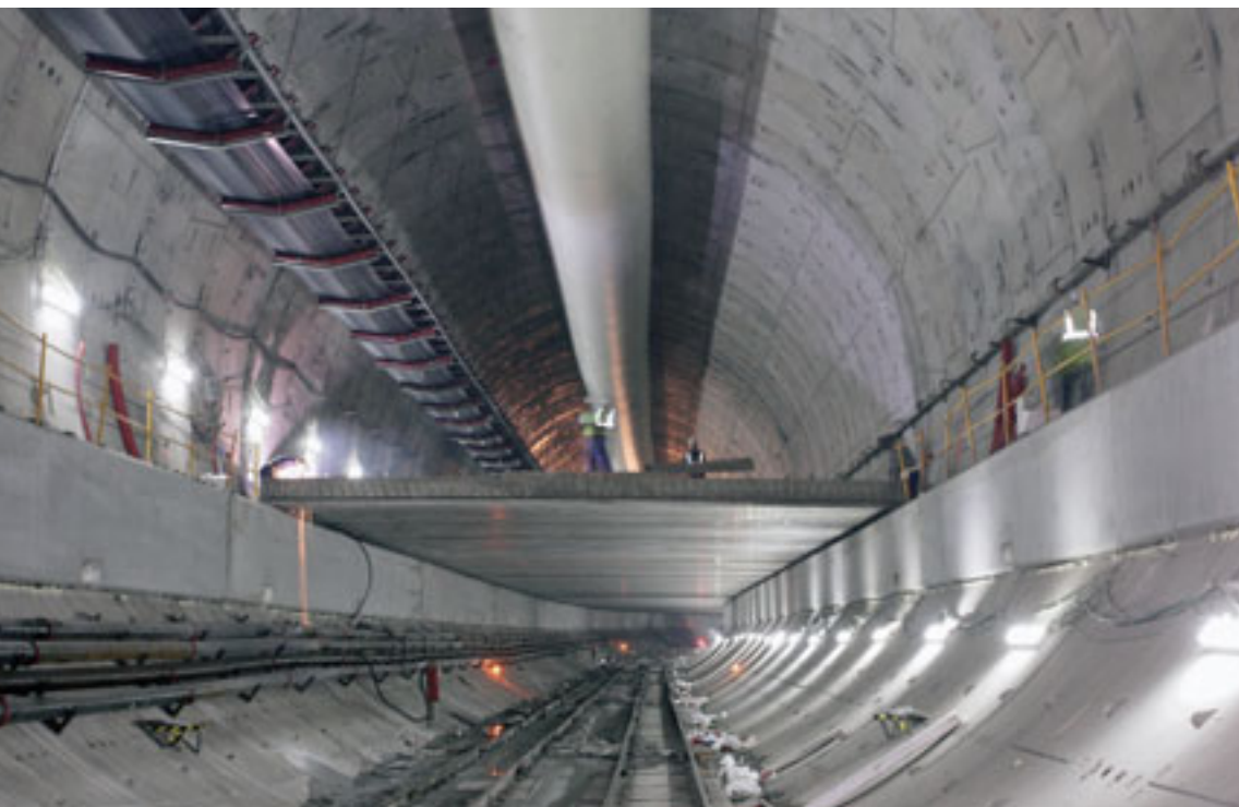
Vista inferior de losas de rodadura colocadas.
