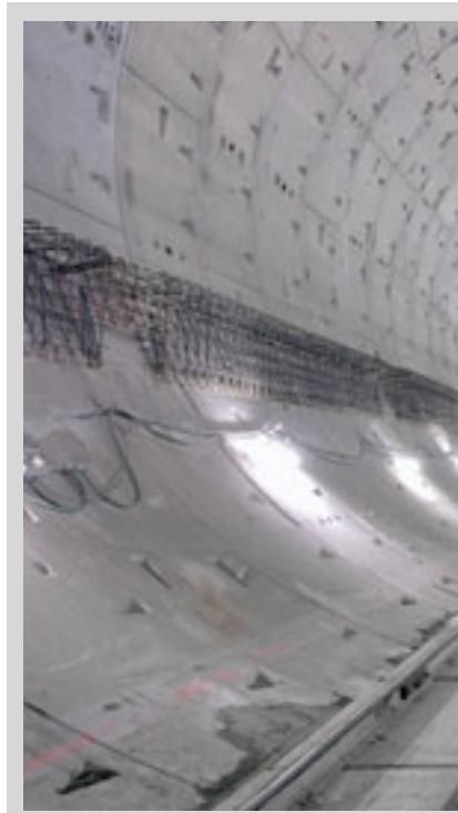
Anclajes de ménsulas.
