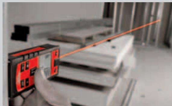
Los perfiles de tabique seco pueden ser posicionados de forma rápida y precisa con los medidores Hilti PD 40 y Hilti PD 42.
