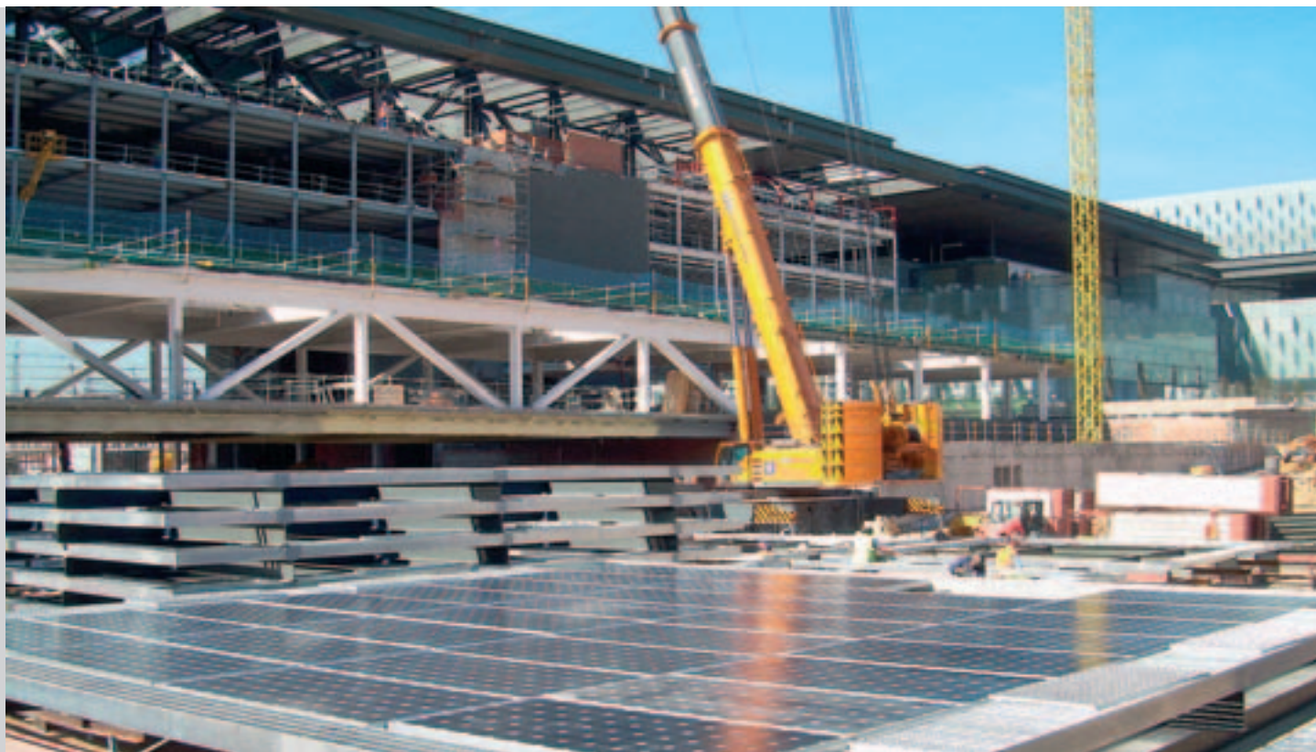
Una celda de paneles lista para ser izada y colocada en su ubicación definitiva
