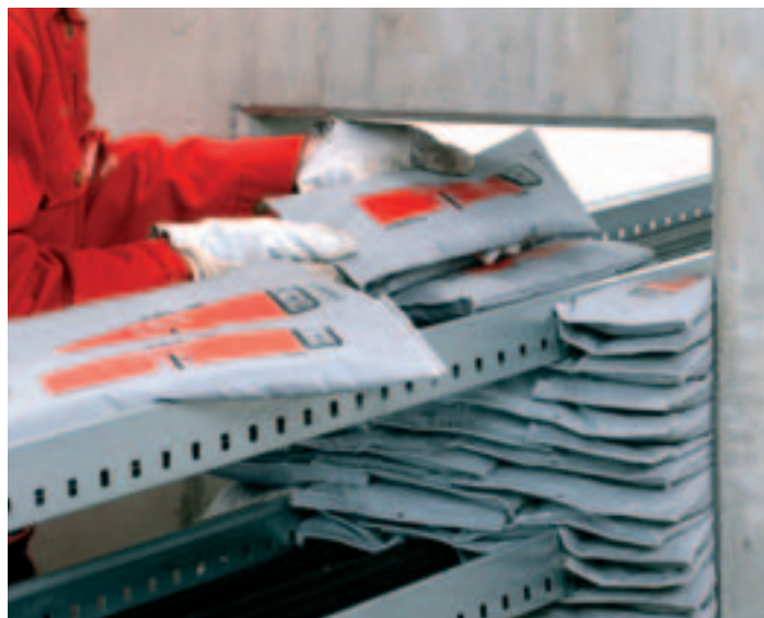
Colocación de almohadillas cortafuegos en un paso de bandejas eléctricas
