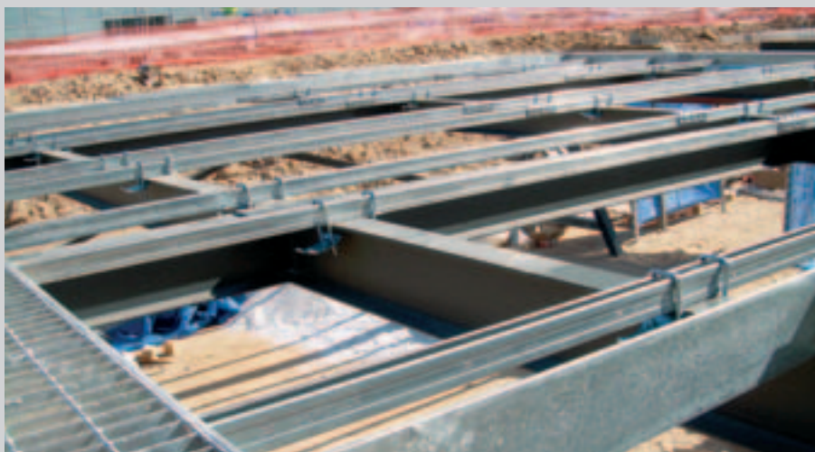
Fases de montaje de las celdas de paneles
