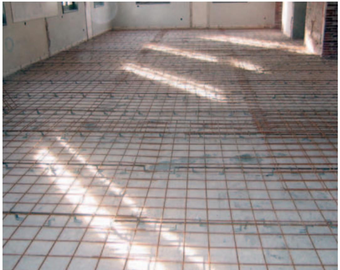
Vista general de conectores en el forjado
