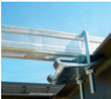
Detalle de la mordaza Hilti MQT-41-82, elemento de unión del carril con la estructura metálica
