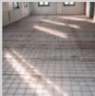
9 Forjados mixtos en rehabilitación
