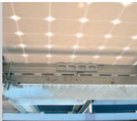
Detalle del montaje con el panel colocado. Se aprecian carriles, perfiles de la estructura, mordazas y paneles
