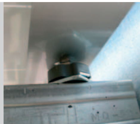
Detalle placa tuerca Hilti MQA-Q, elemento de unión rápida del panel al carril
