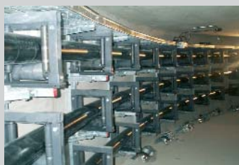
Nuevas instalaciones del Aeropuerto de Barajas
