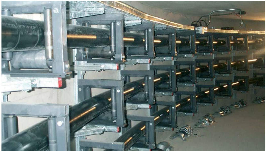
Tendido de cable en tramo curvo.
