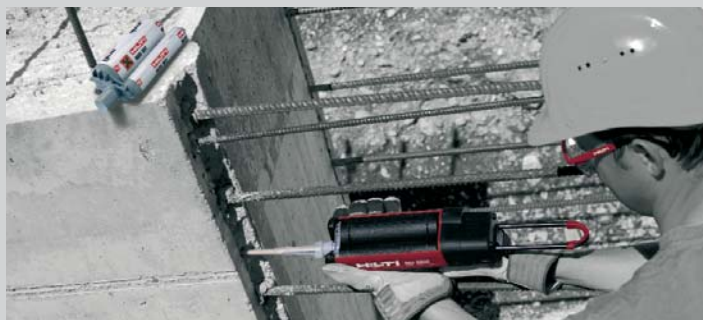
Fig.3 Proceso de Inyección
