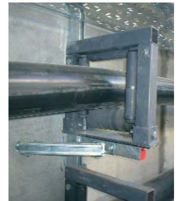
Detalle tendido de cable
