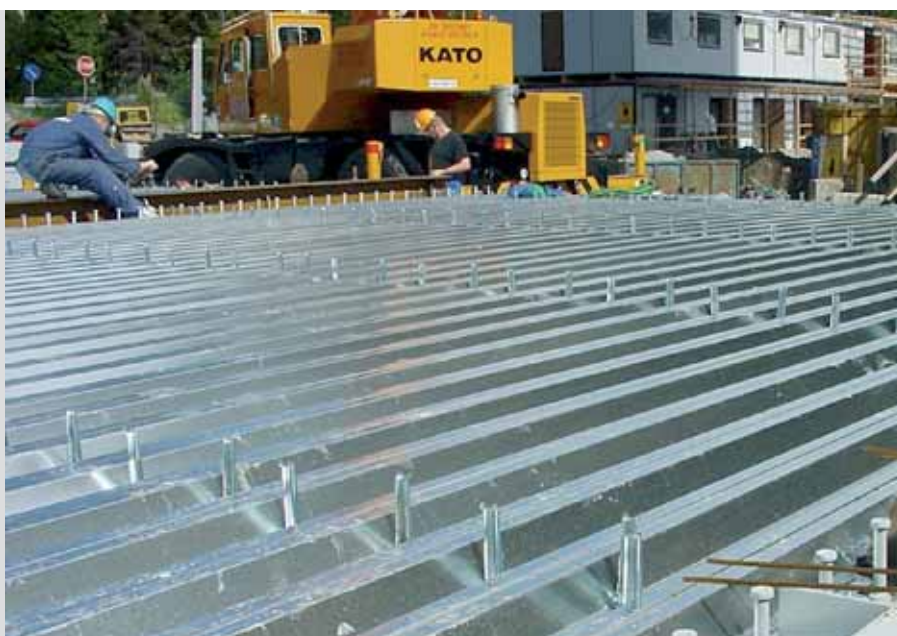
Conectores colocados hasta el momento con el primer clavo
