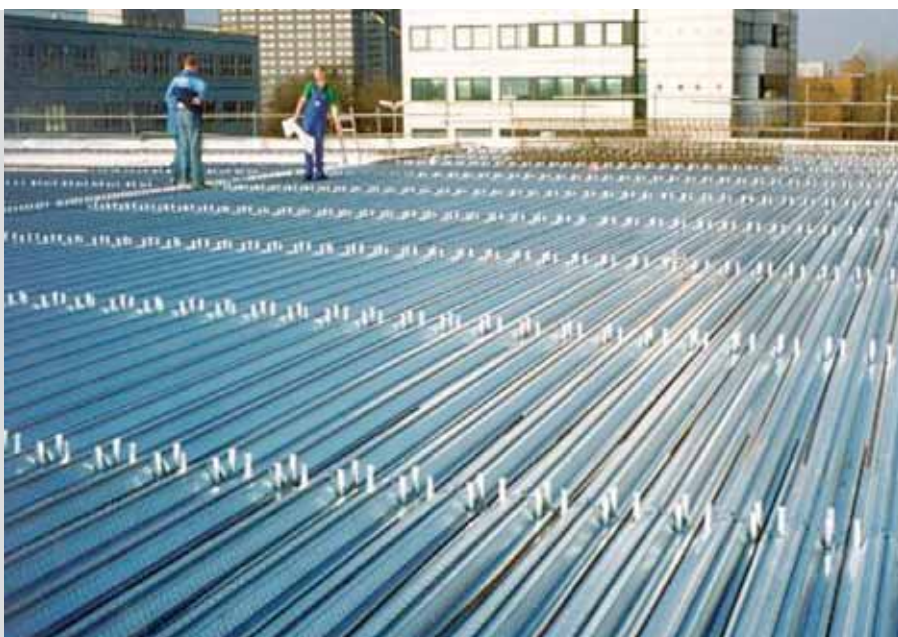
Vista general de los conectores colocados
