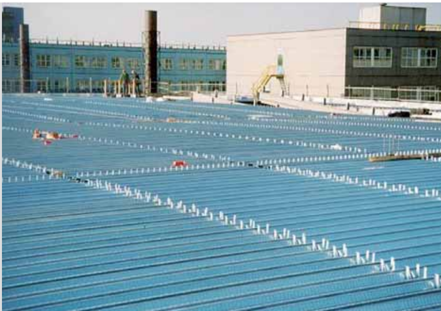
Finalización de la colocación de los conectores
