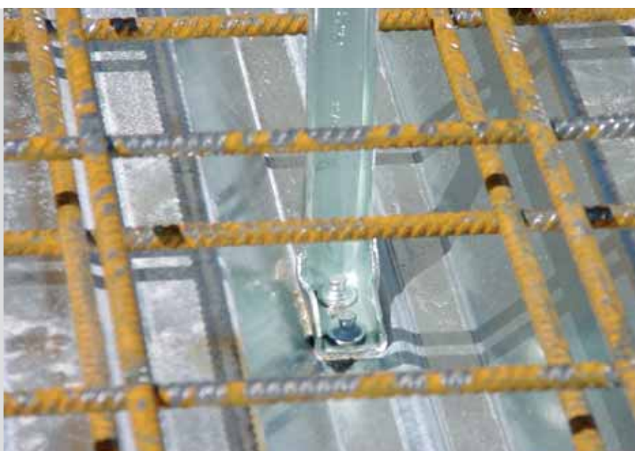
Colocación de la eventual armadura adicional
