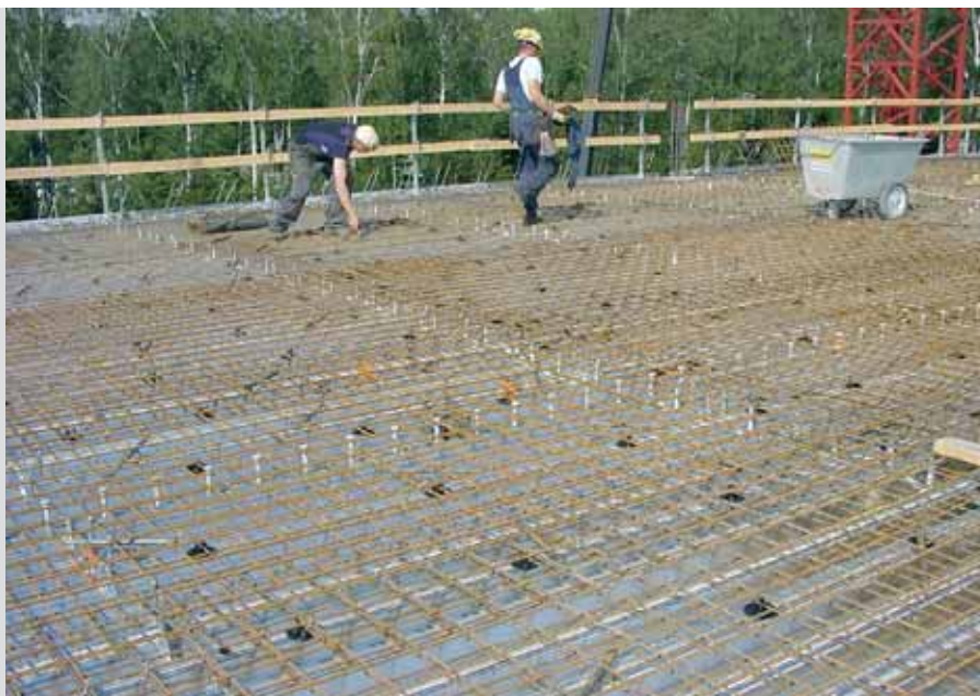
Colocación del mallazo sobre los conectores antes de hormigonar
