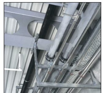
Estructura con sistema MN fijadas a vigas de acero
