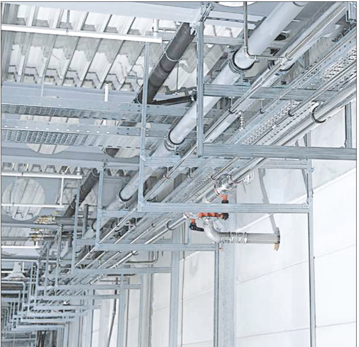
Tendencias en la instalación de tuberías: Sistemas modulares de tuberías para distintas líneas de procesos.
