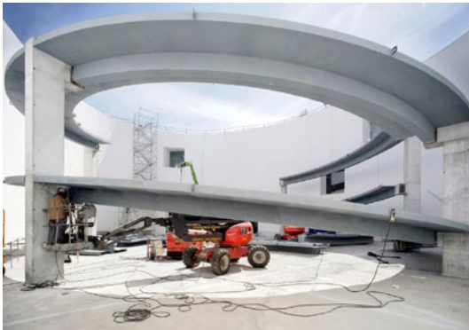
Fases del montaje de la rampa helicoidal.
