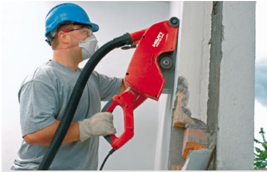
La cortadora DGH 230 incorpora carcasa para recoger el polvo y se recoge mediante aspirador.
