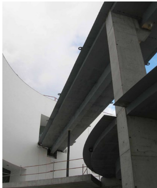
Fases del montaje de la rampa helicoidal.
