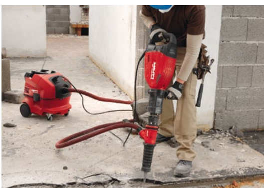
Rompedor TE 1000 utilizando sistema anti-polvo DRS y aspirador para recoger el polvo.
