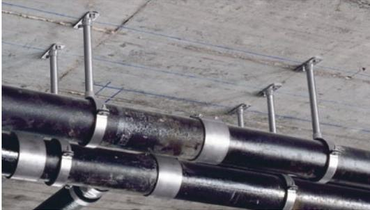
Que el anclaje trabaje en toda su longitud tiene numerosas implicaciones: nos permite tener menor separación entre anclajes y a borde, (en relación a otro tipo de anclajes HSA/HST), nos permite asegurar el anclaje a pesar de encontrar coqueras o materiales huecos, nos asegura un mejor comportamiento frente a taladro con suciedad...
