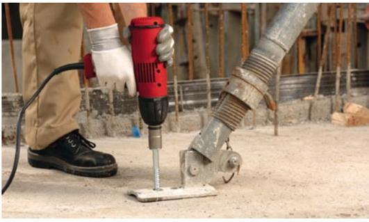
Durante la colocación, la rosca del anclaje va penetrando en el hormigón, logrado así que el anclaje se produzca en toda la longitud y no solo en la cabeza.
