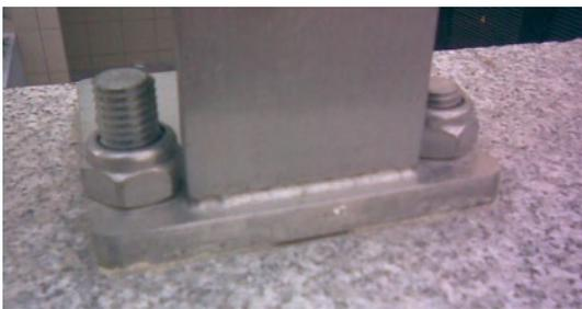
**Rapidez y sencillez en la instalación:** La colocación del anclaje tipo HUS se realiza sobre un pretaladro de diámetro inferior. Posteriormente el anclaje es introducido con la ayuda de una atornilladora de impacto.
