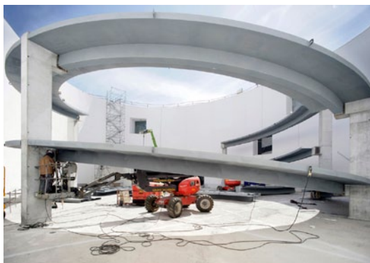
Fases del montaje de la rampa helicoidal.
