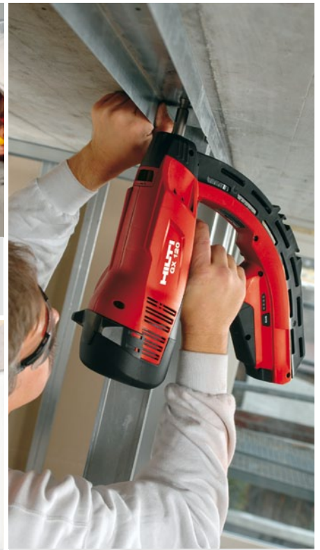
GX 120 : fijaciones sin cable y sin batería.
