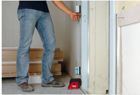
PMC 36 : puntos y líneas en la misma herramienta.
