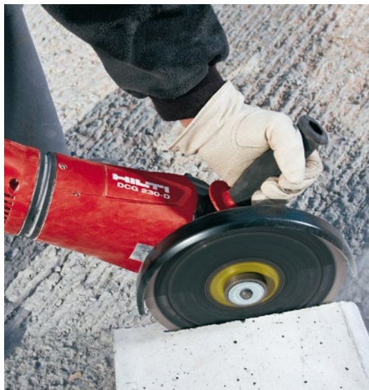
Corte de materiales minerales (hormigón, piedra natural, mampostería,...).
