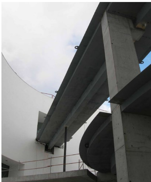
Fases del montaje de la rampa helicoidal.
