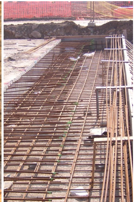
Recrecido de petos, conexiones de pequeña entidad.
