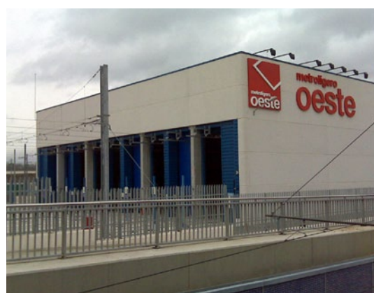
Vista exterior de las cocheras de Metro Ligero Oeste.
