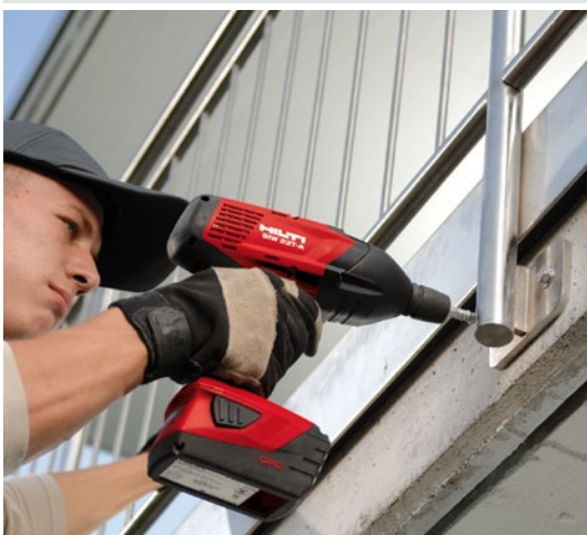
Colocación de anclajes de rosca externa HUS 10-14 mm en hormigón.
