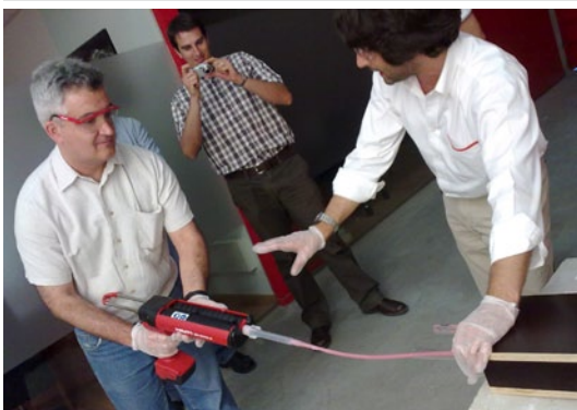
Demostración HIT de montaje de barras corrugadas durante la jornada en Valencia.
