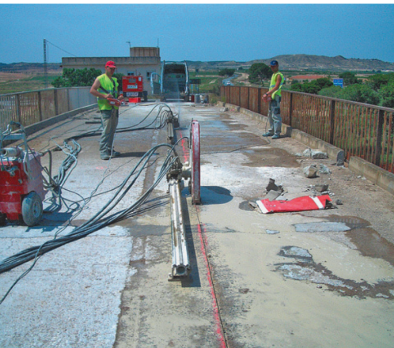
Cortes de losas de suelo de puente para su posterior extracción con grúas.
