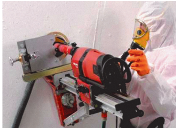
El taladro en seco de hormigón armado empezó en centrales nucleares.
