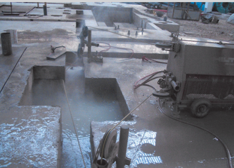
La Hilti DS-WS 15 es un equipo totalmente eléctrico y de accionamiento neumático de alta capacidad.
