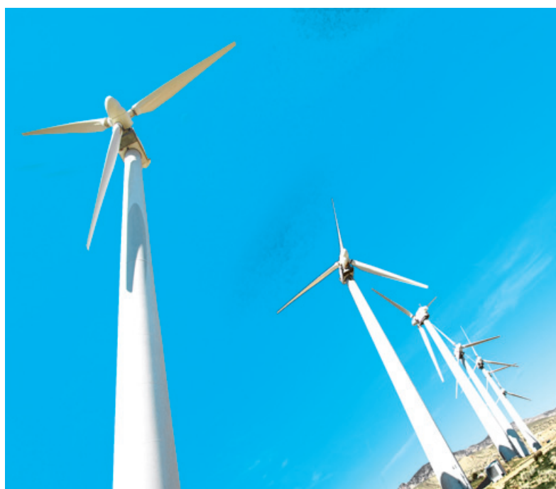
La obra de los parques eólicos duró 9 meses..
