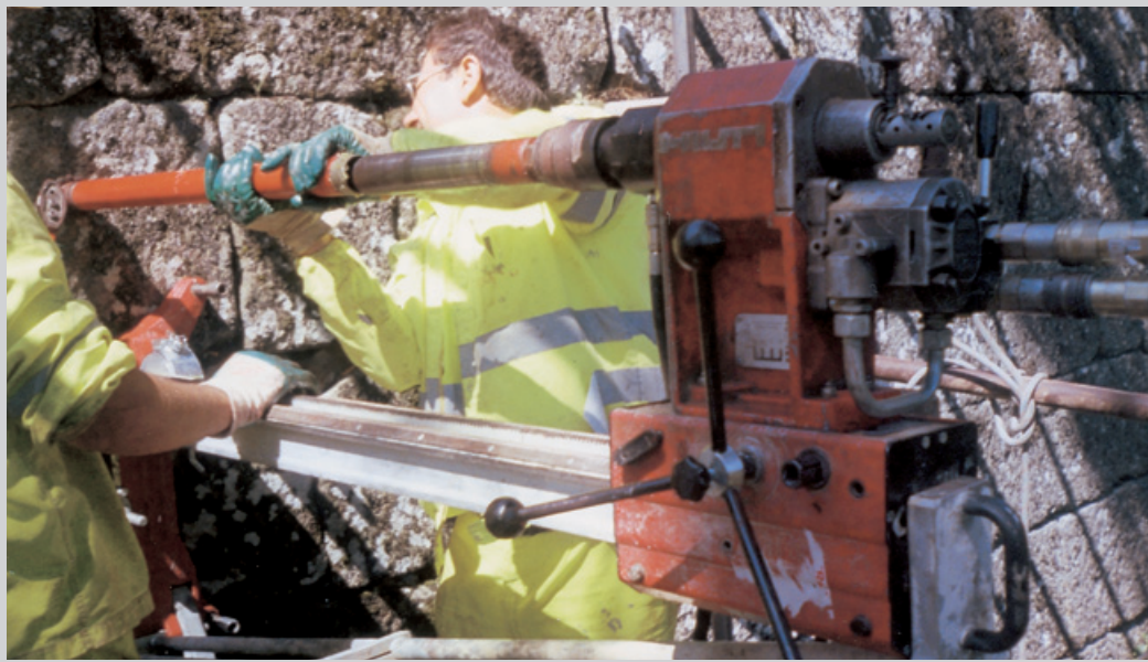
La perforadora hidráulica Hilti DD 750 puede taladrar hasta un diámetro de 1000 mm.
