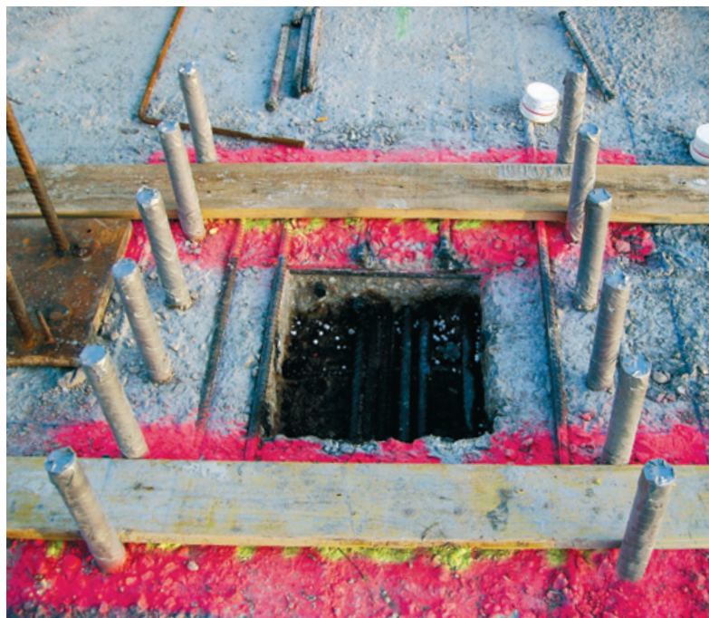
Recuperar las esperas era el objetivo de las perforaciones a realizar.
