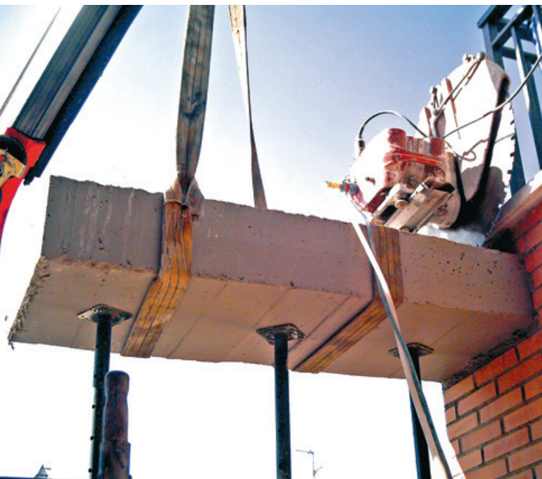
Con una potencia de 5 kW a 16 A y una profundidad máxima de 31 cm, el Hilti DS-TS 5-E es un equipo eléctrico muy versátil para cortes pequeños.
