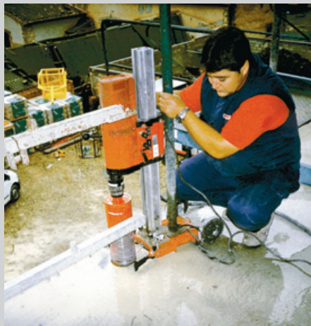
Una Hilti DD 250 perforando en obra con puntal.
