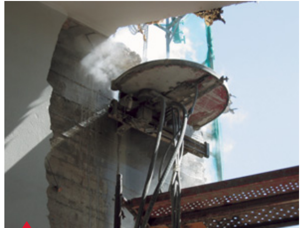
Dentellada usando el corte con disco con el equipo Hilti D-LP 32.
