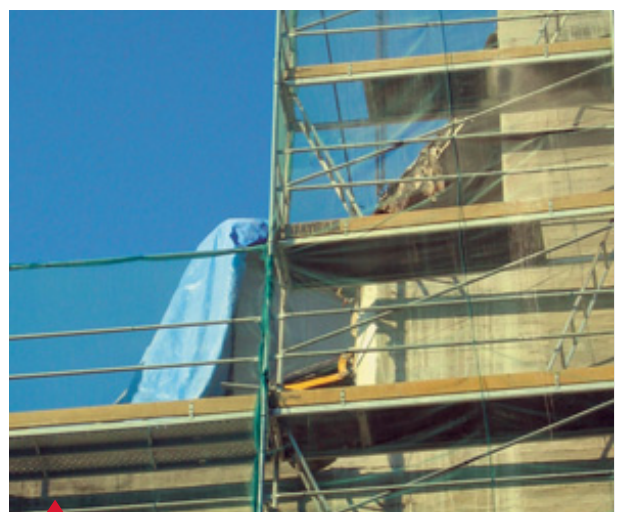
Detalle del proceso de demolición, ejecutado con limpieza y sin vibraciones.
