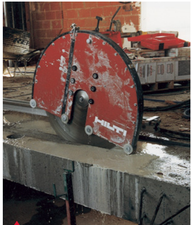
El equipo de corte mural hidráulico de Hilti D-LP 15 realizando trabajos de rectificación en forjados.
