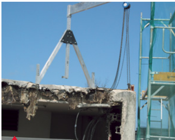
Caballote de aluminio usado para evacuar piezas hasta un peso de 1.500 kg.
