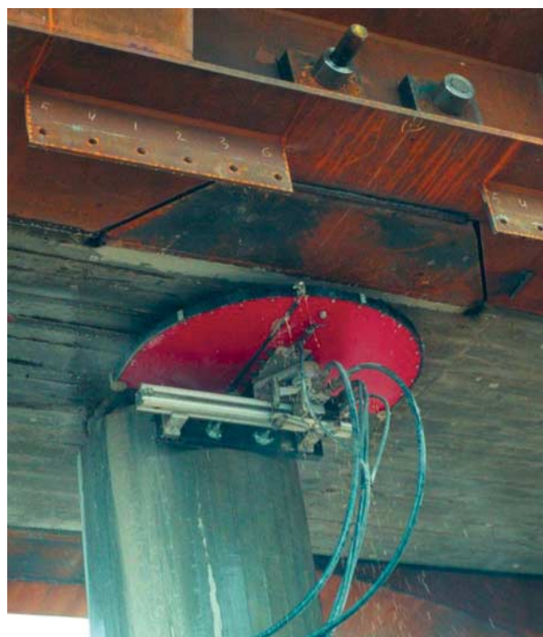
Cabezal de corte Hilti sobre una base curva adaptada al pilar.
