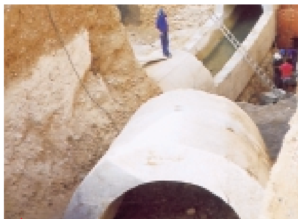
Una vez separada la parte superior de la tubería, ARACORTE cortó la base con el equipo de hilo Hilti DS-WSS 30.
