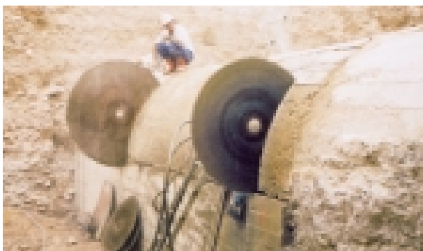
El cortamuros hidráulico Hilti D-LP 30 durante el corte de la parte superior de la tubería con disco de Ø 1600 mm para hormigón.
