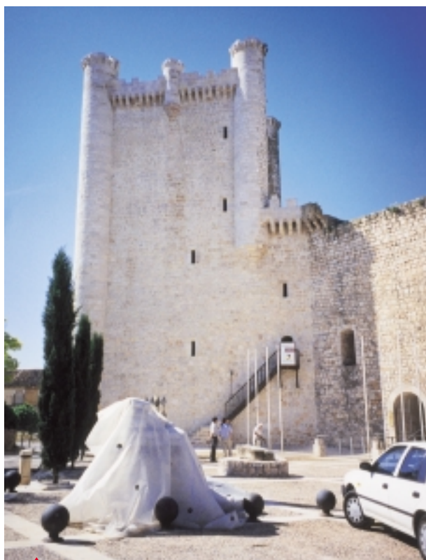
El Castillo de Torija es sólo un ejemplo más de los trabajos en rehabilitación del patrimonio.
