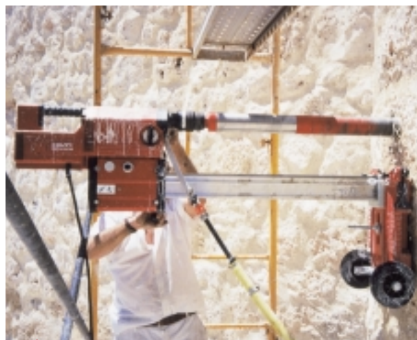
Taladro con la potente DD 250 y baterías roscadas Hilti con segmento de diamante para roca.
