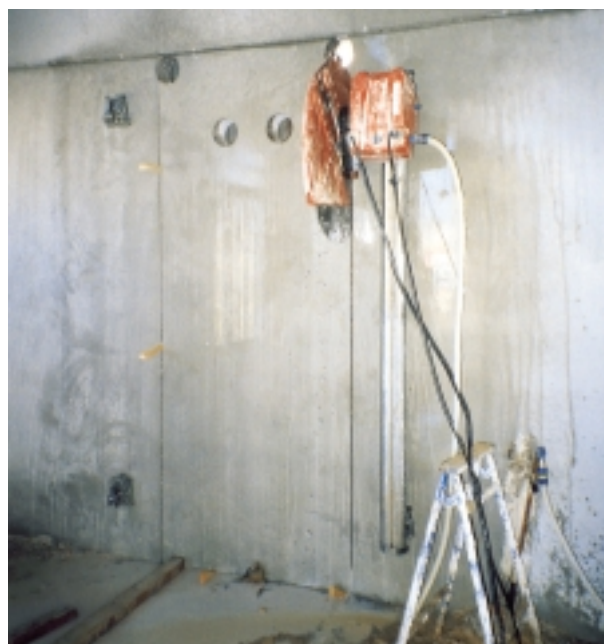
El cortamuros eléctrico DS-TS5 E para cortes hasta 28 cm de profundidad.
