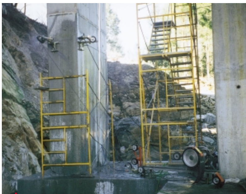
Corte de pilares.
