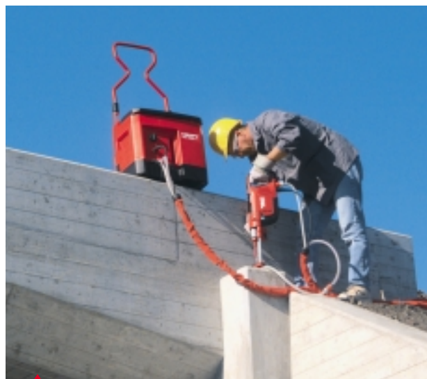
Vista del equipo DD EC-1 taladrando con la unidad de reciclado DD-REC 1.
