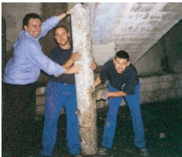
Parte del testigo resultante del taladro. En la foto empleados de CASEVAL y Carlos Navarro, comercial Hilti de Valencia.
