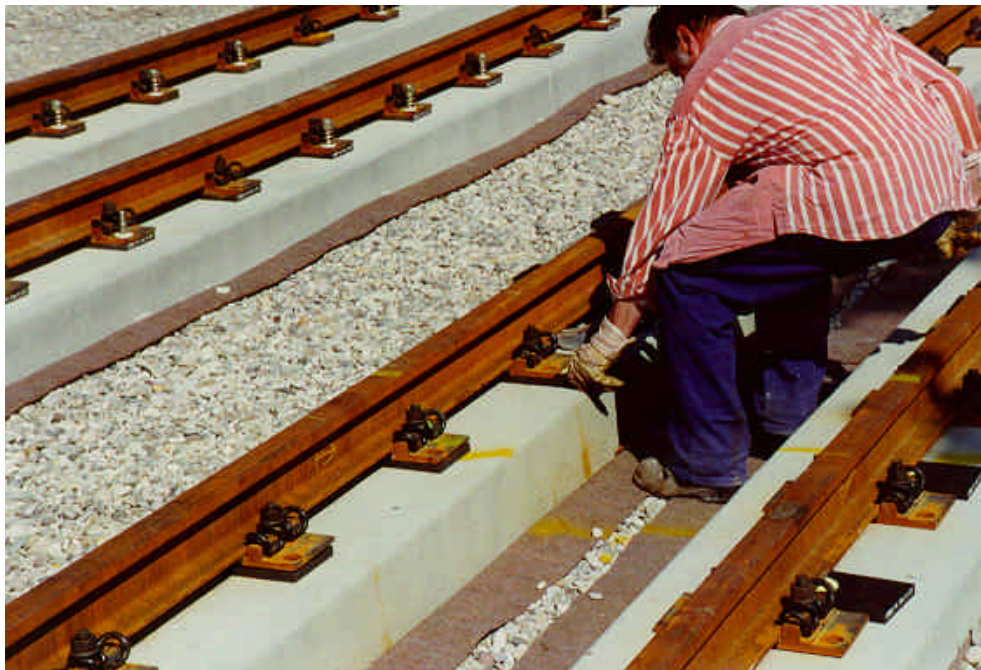
Colocación del aislamiento Getzner
