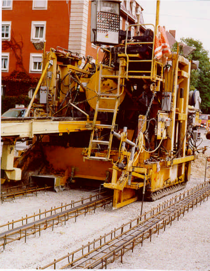
Pavimentación continua con refuerzo de armadura
