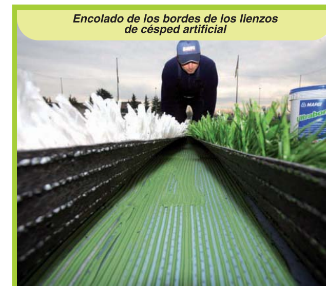
Comprobación del mojado del reverso del manto
