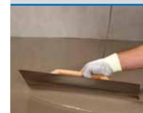
► Lisciatura autolivellante ad indurimento ultrarapido per spessori da 1 a 10 mm, a bassissima emissione di sostanze organiche volatili (VOC).
