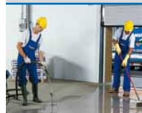
► Lisciatura autolivellante a rapido indurimento, per spessori da 3 a 10 mm.
