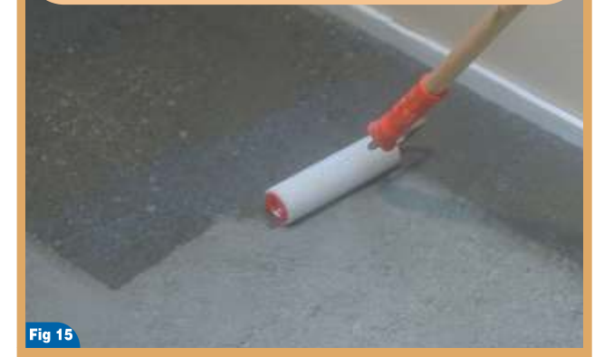
Aplicación de PRIMER G con rodillo sobre recrecido cementoso
