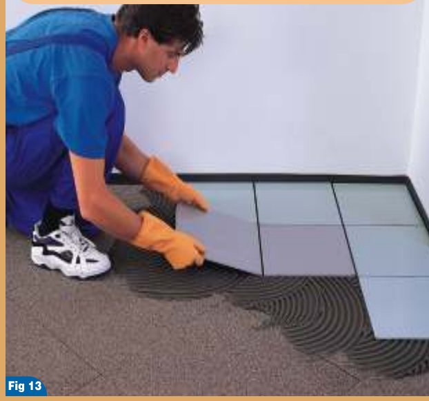
Colocación de gres porcelánico pulido sobre MAPEFONIC PÁD con MAPEFONIC MORTAR
