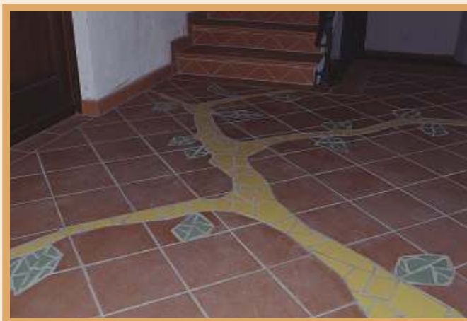
Baldosas de terracota y gres porcelánico colocadas con KERABOND , rejuntadas con KERACOLOR y tratadas superficialmente con KERASEAL .
