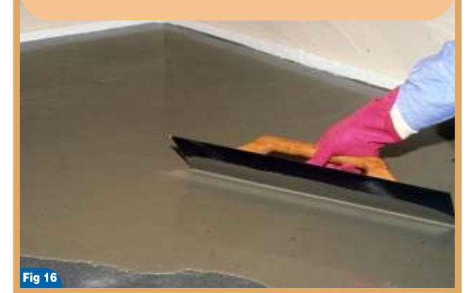
Aplicación de enlucido autonivelante
