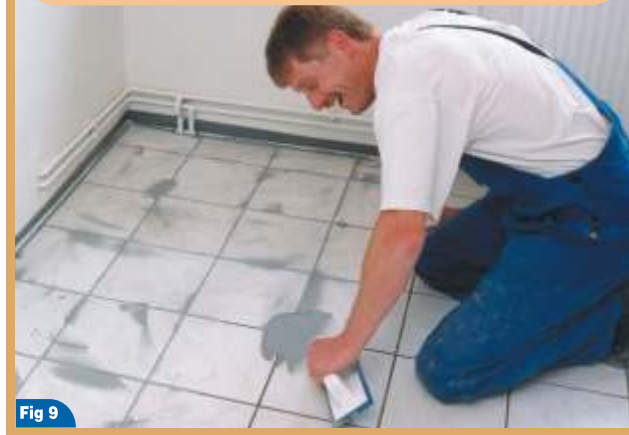
Rejuntado de las baldosas
