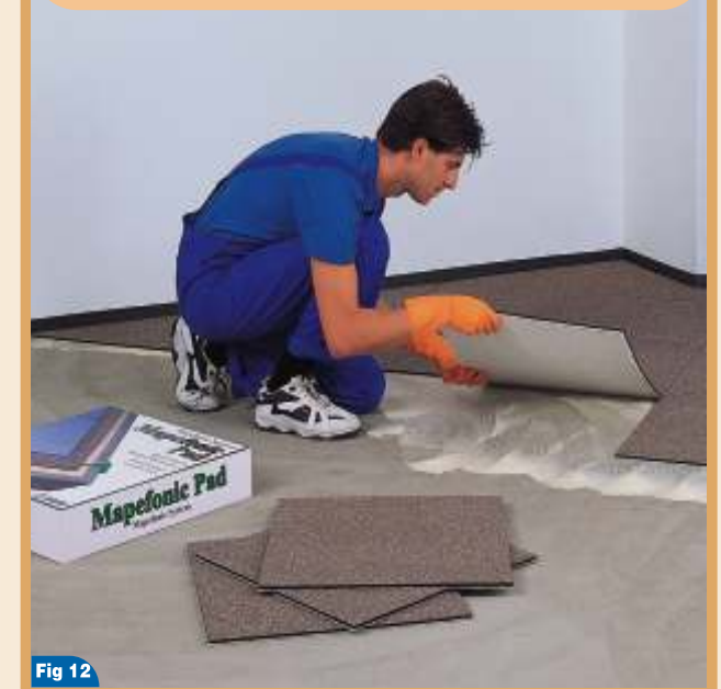
Aplicación de MAPEFONIC PAD con MAPEFONIC GLUE
