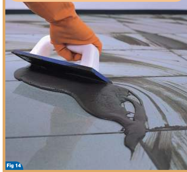
Relleno de juntas con MAPEFONIC GROUT
