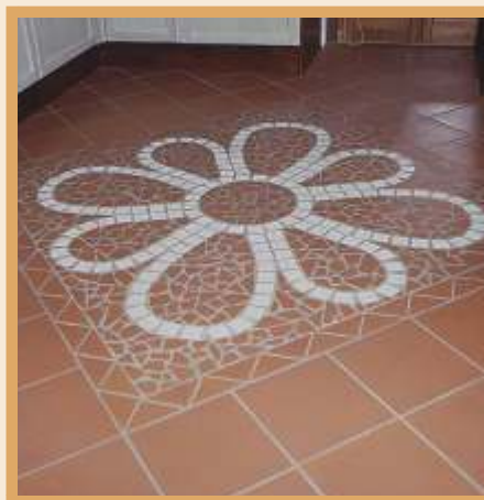
Baldosas de terracota y gres porcelánico colocadas con KERABOND , rejuntadas con KERACOLOR y tratadas superficialmente con KERASEAL .
