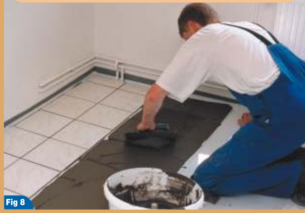
Colocación de las baldosas sobre MAPETEX con KERAQUICK+LATEX PLUS
