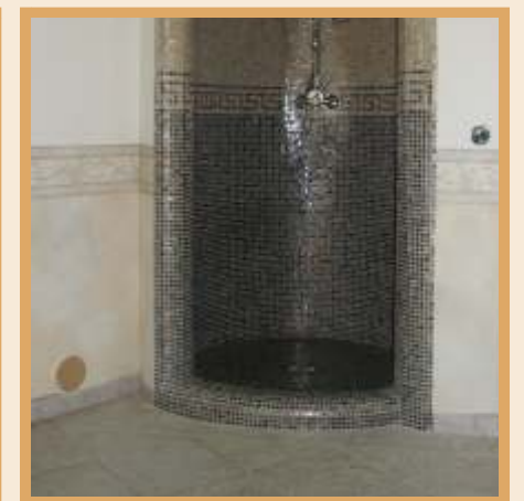
Para la colocación de la cerámica han sido utilizados ADESILEX P9 , KERABOND+ISOLASTIC , KERALASTIC y KERAFLEX . El rejuntado ha sido realizado con ULTRACOLOR
