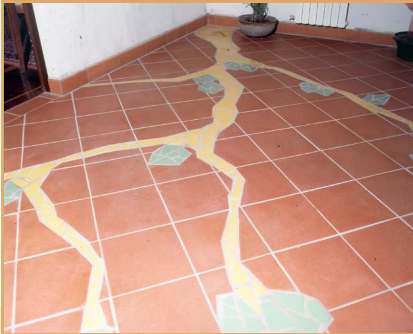
Los pavimentos de terracota con inserciones de gres porcelánico han sido realizados según un diseño original que personaliza cada ambiente.
