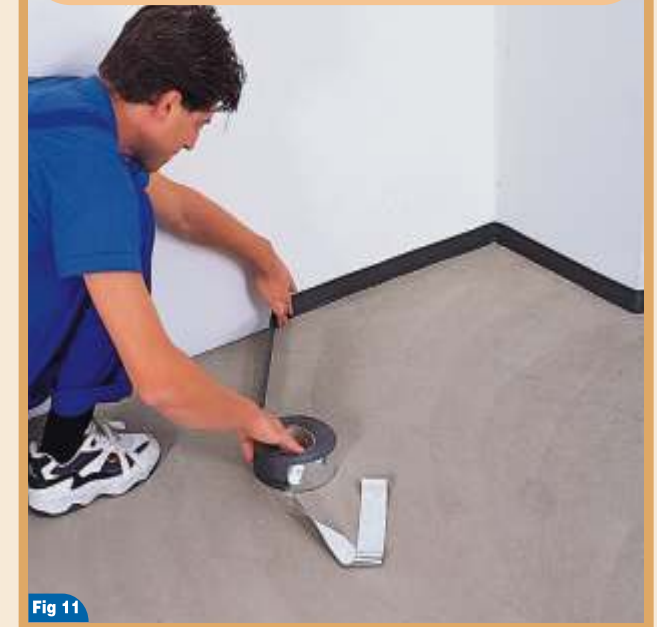
Aplicación de MAPEFONIC STRIP a lo largo del perímetro del local
