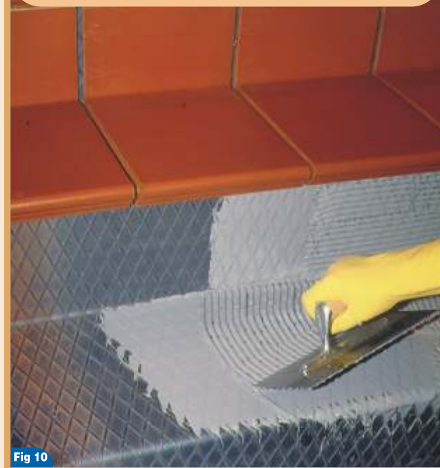
Colocación de terracota sobre peldaños de metal con KERALASTIC
