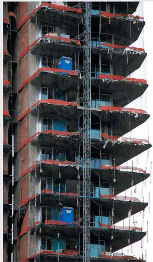
Edificio en obras
