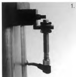
1. Grupo de sensores de proximidad con soporte.
