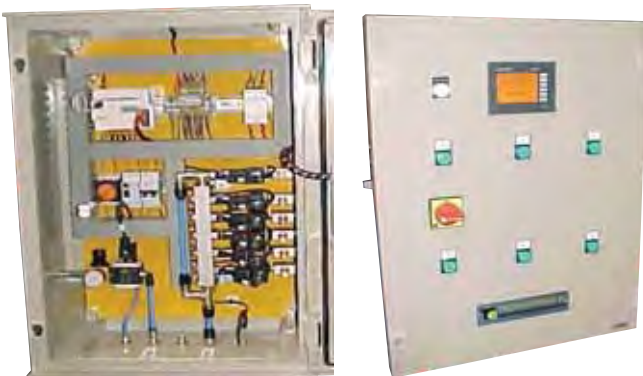
Cuadro de control para sistema de lubricación, industria alimentaria.
