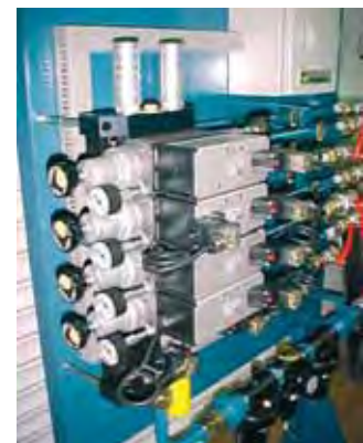
Panel electroneumático para planta de galvanizado.
