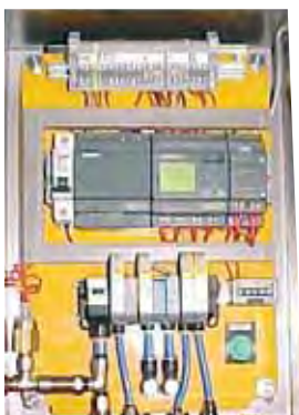
Cuadro de control para el tratamiento superficial de cubas de transporte de arrabio en acería.
