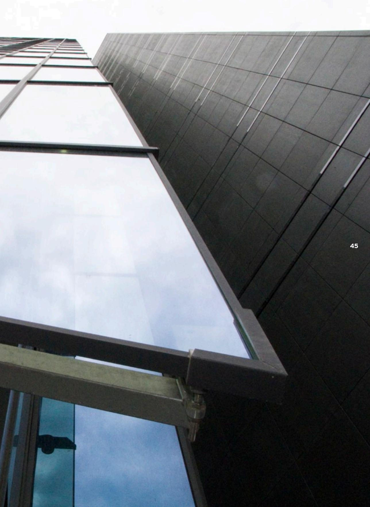
**LOS ELEMENTOS TRIANGULARES DE HORMIGÓN ARMADO FORMAN UN NÚCLEO EN X Y OFRECEN PROTECCIÓN FRENTE A LOS TERREMOTOS**
