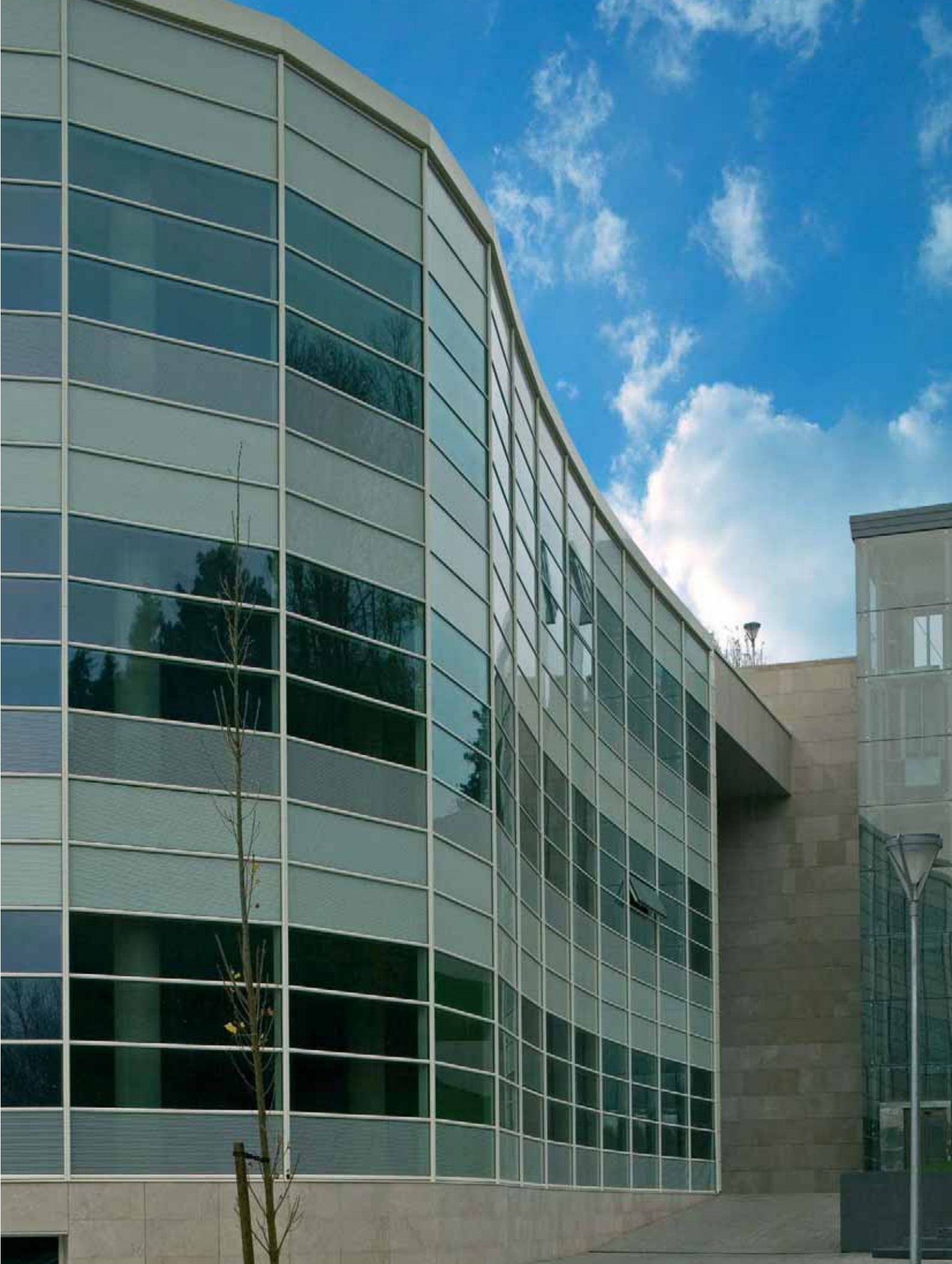
Edificio A1.1, Parque Tecnológico Miramon · San Sebastián (España) Arquitecto: Joaquín Montero Basqueseaux
