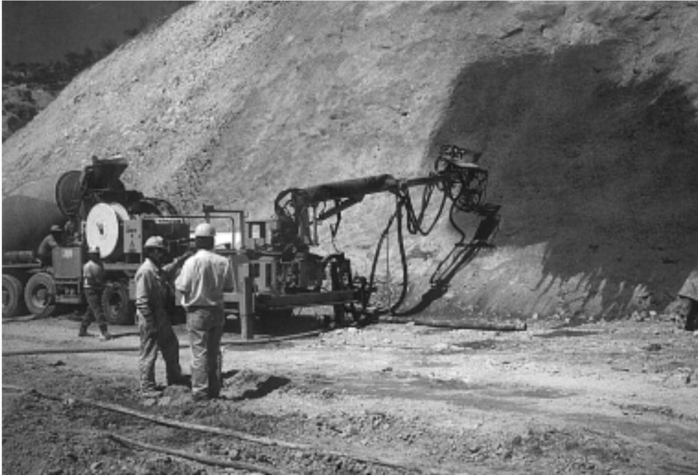
Fig. 8. Robot de proyección por vía húmeda.
