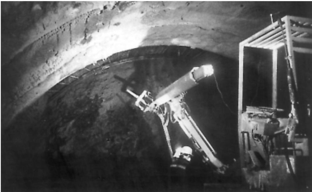
Fig. 1. Aplicación del hormigón proyectado en el sostenimiento de túneles.
