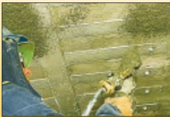
Aplicación por proyección para pruebas bajo cargas dinámicas.
