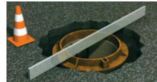
Colocar y nivelar la pieza sobre la capa base.
