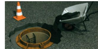
Verter el Sika® FastFix 138-TP amasado con consistencia plástica para el relleno final de la pieza.
