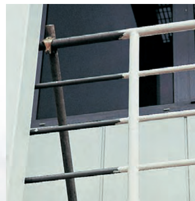
El Icosit 6630 high-solid se aplicó durante la restauración directamente sobre la barandilla galvanizada.
