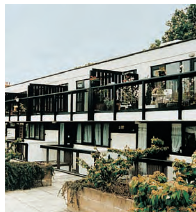
Balcones privados y terrazas impermeabilizados con tiempos de espera mínimos usando Sikafloor EpoCem
