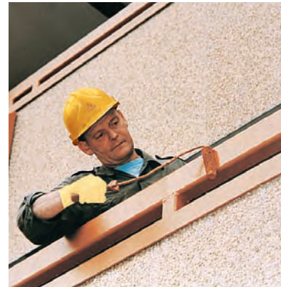
Aplicación de una sola capa Icosit 6630 high-solid directamente sobre los pasamanos galvanizados del parapeto
