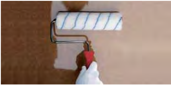
Aplicación de una imprimación con un rodillo de pelo medio-largo
