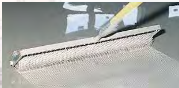
Rodillo de púas de nylon para la eliminación de aire ocluido en sistemas autonivelantes
