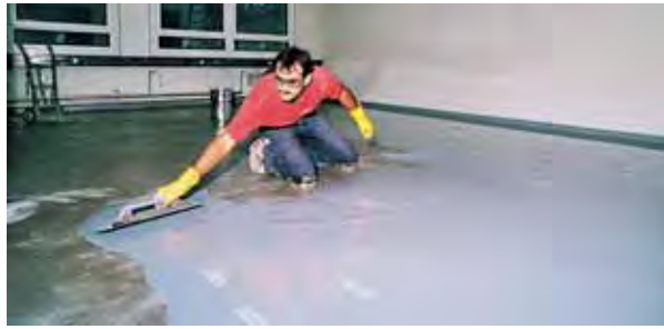
Aplicación de un mortero autonivelante con llana dentada
