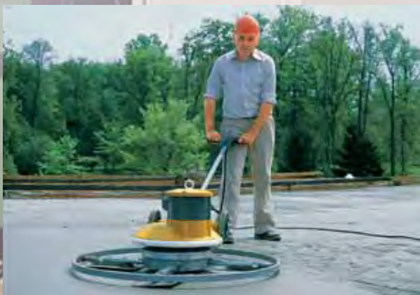
Helicóptero con control de velocidad para el pulido de pavimentos de hormigón y de resinas
