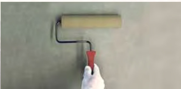
Sellado de un pavimento autonivelante utilizando un rodillo de pelo corto
