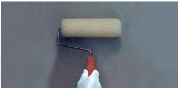
Aplicación de Sikafloor®-261 + Extender® T mediante rodillo texturado
