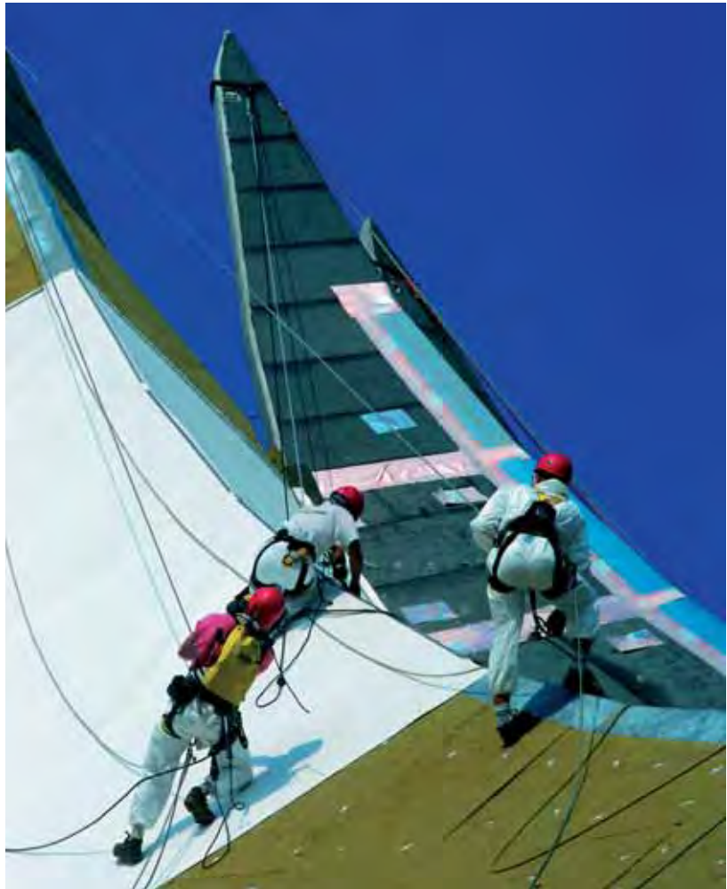
Aplicación de membrana en Tempodrom, Alemania
