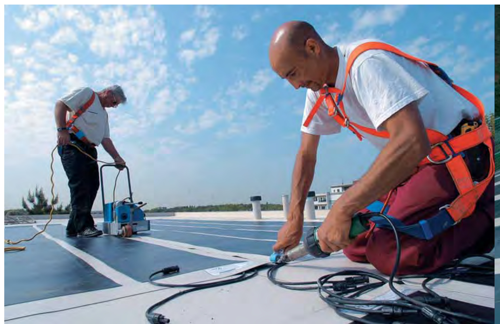
Soldadura racional de Módulos-PV
